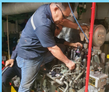
Perbaikan Mesin Genset
